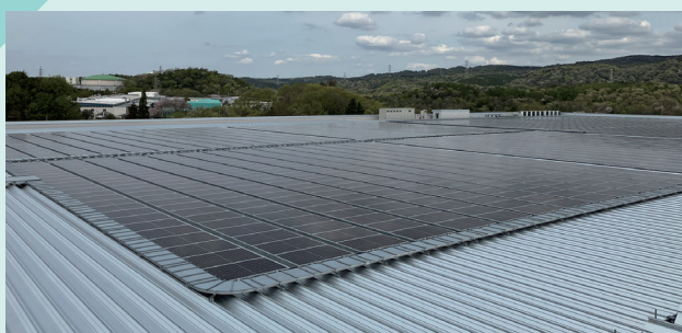
工場の屋根に設置している太陽光発電システム (パネル容量 1,312kW)
