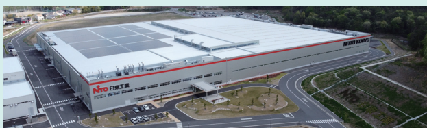
工場の屋根に設置している太陽光発電システム (パネル容量 1,312kW)
