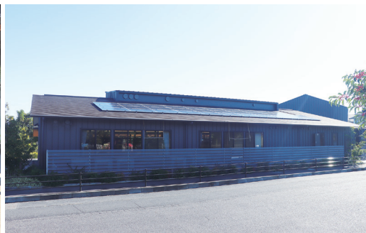
実証事業第1号建物 指定避難所でもある北小校区共生ステーション
