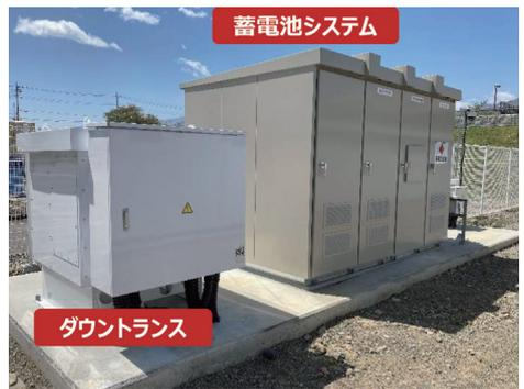
して生産しています。また、2024年4月には、山梨工場に太陽光発電・蓄電池システムを設置、自家消費型として工場での使用電力の一部を賄うだけでなく、製品開発の実証実験にも活用しています。
