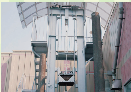
衝撃試験設備
